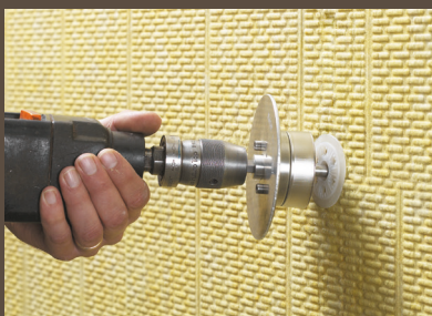
Skrú og fræs dyblen ind i isoleringen i én arbejdsgang.
