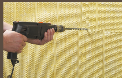
Bor hullet med 8 mm bor.
